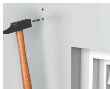
**Passo 1:** Com o auxílio da trena e um lápis, faça as marcações de referência para a instalação dos suportes. Considere mais 10 cm nas laterais do vão e mais 10 cm do topo do vão, ou conforme as medidas da sua Cortina Rolô.
